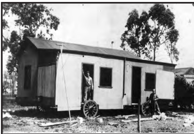
Foto 13. Traslado de una casa (Gentileza MHP).
