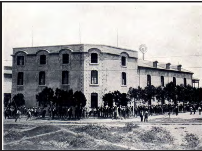
Foto 11. La “Casa de la Empresa” 20 .
